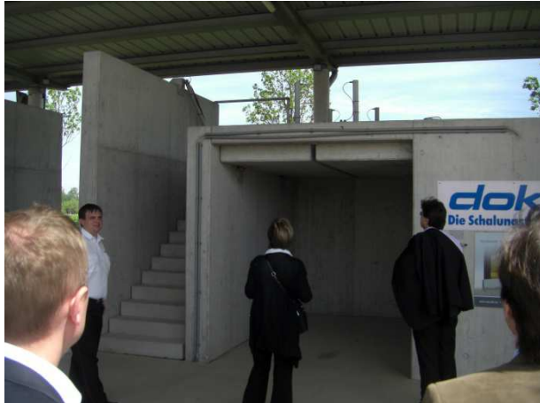
Byggnadsras (2 betongluckor med gångjärn)
